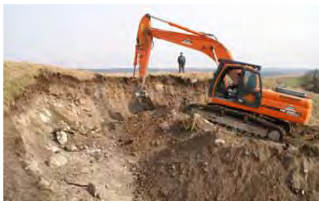
Abb. 12: Beräumung der Schutt- und Erdablagerungen mit schwerer Technik (PG 3, NSG Spatenberge) (Foto: H. Baumbach, 3/2012).
